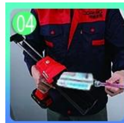
04 Tornilyo sa nozzle, ilagay sa gun grout
